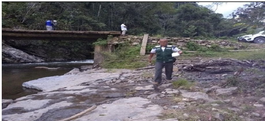
Imagen1.-Se aprecia colmatacion del cauce y densa vegetacion de cauce
